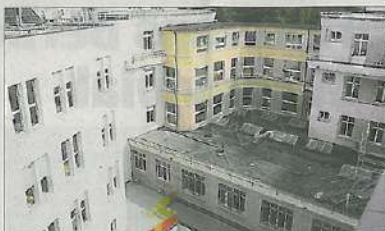
L'ancienne clinique (à droite) et le nouveau bâtiment sont reliés à tous les étages.
